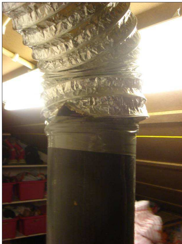
Stankoverlast op zolder door een lek in de standleiding.
