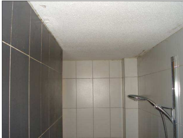
Afzuiging op verkeerde locatie. De afzuiging bevindt zich aan andere kant van de badkamermuur. Dit veroorzaakt schimmel in de douche.
