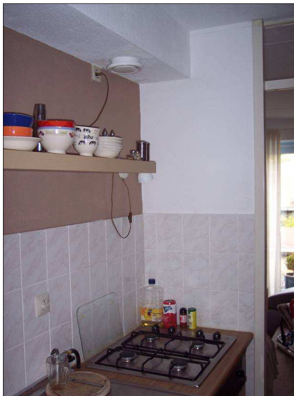
Te laag afzuigvermogen, waardoor er stankoverlast ontstaat bij het koken.
