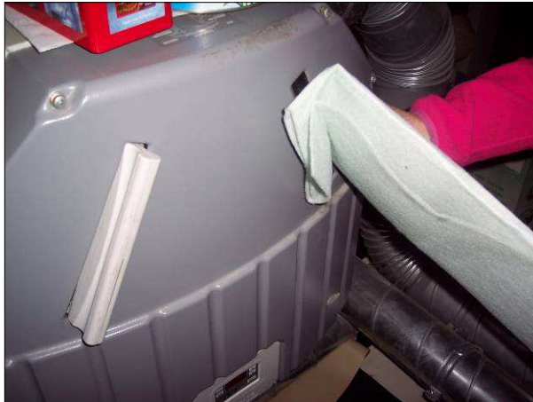
Bewoner vervangt de filters op een geïmproviseerde manier.
