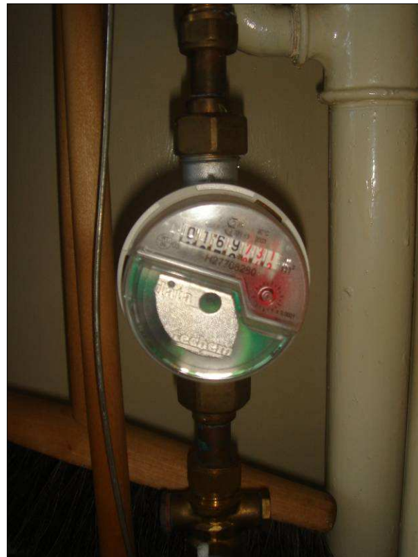
Het bemeten en afrekenen van de collectieve installaties heeft in eerste instantie te weinig aandacht gekregen. Er zijn nu doorstroommeters geplaatst voor koud tapwater, warm tapwater en CV.
